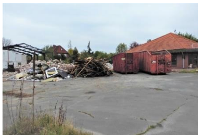
Abbruch des Haupthauses im Juni 2019
